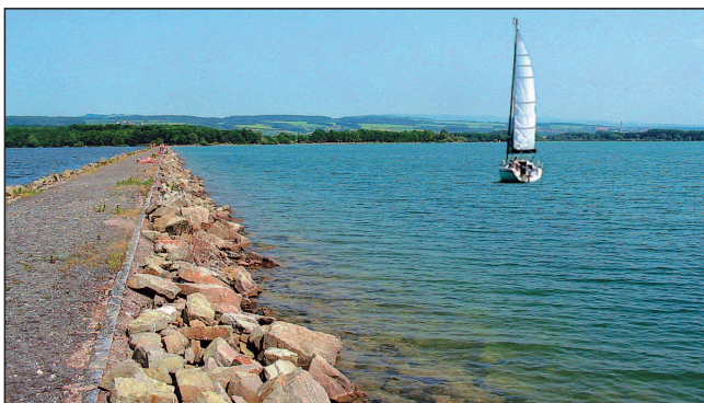
Dělicí „Rovenská“ hráz na vodní nádrži Rozkoš
